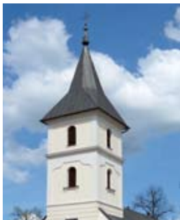
▲ Wieża po przebudowie w 2011 r.
